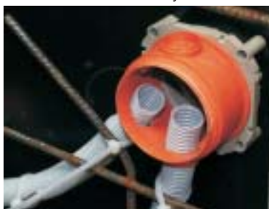
Namontované ohebné trubky do tělesa KBT.
