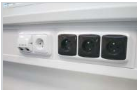
Příklad montáže parapetního kanálu PK 140X70 D.
