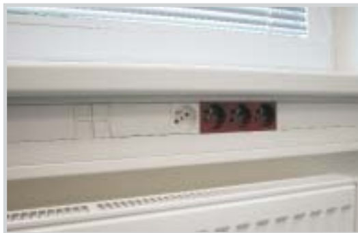
Příklad montáže parapetního kanálu PK 120X55 D.
